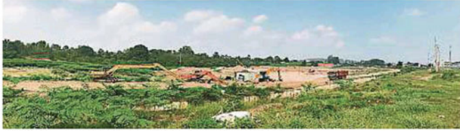
▲承包商正在赶建滞洪池，以期在年杪雨季来临前完工。
